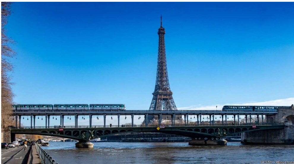
Ancien et nouveau matériel roulant (MP73 / MP89) sur la ligne de métro 6.
