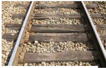
Rails courts sur traverses bois
